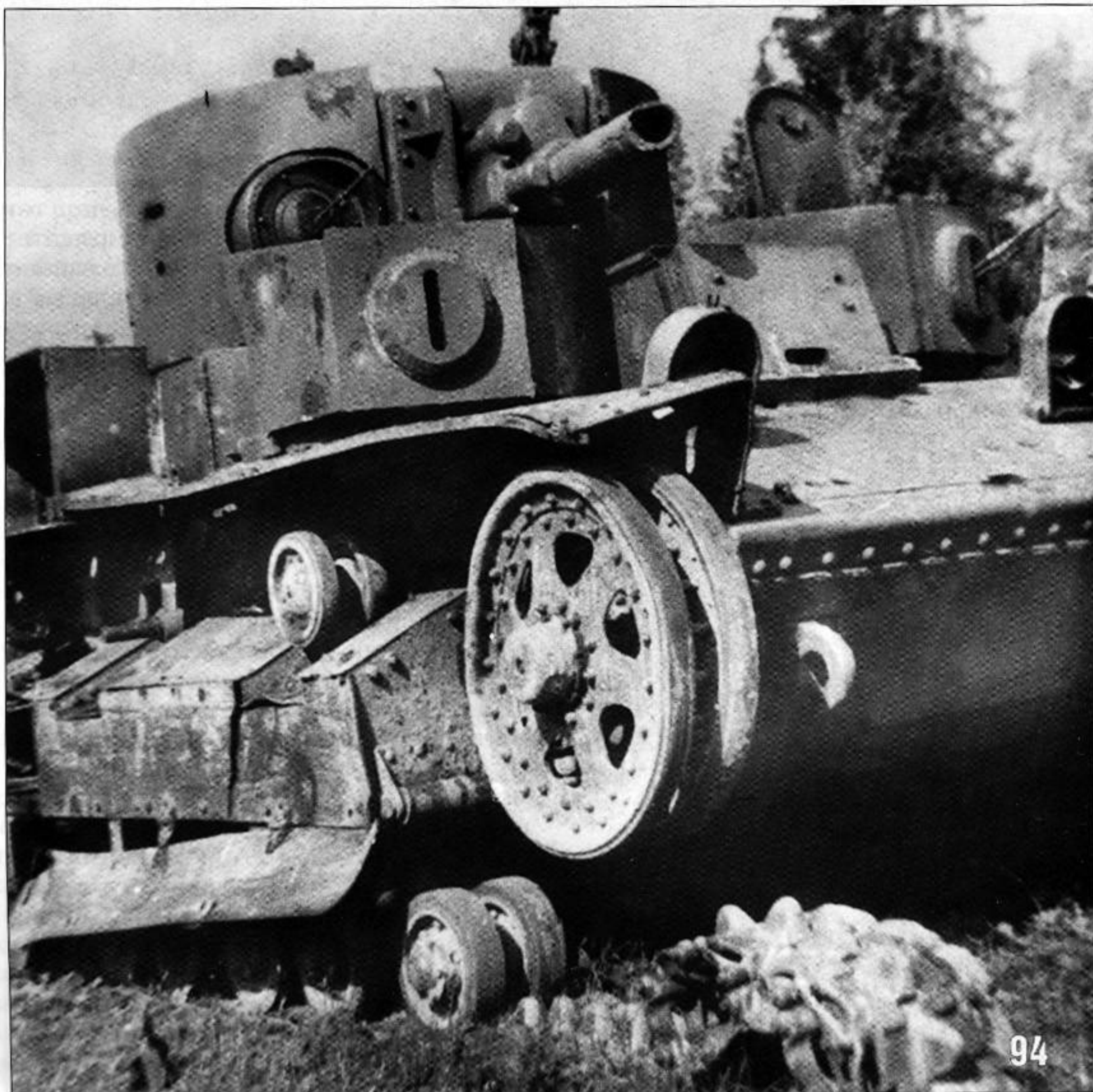
93, 94. Экранированный танк Т-28, подбитый немецкой артиллерией. Район Красногвардейска, август 1941 года. На фото 8-21 видно как минимум пять попаданий в танк 37 — 50 мм бронебойными снарядами, но нет ни одной пробоины (АСКМ).
