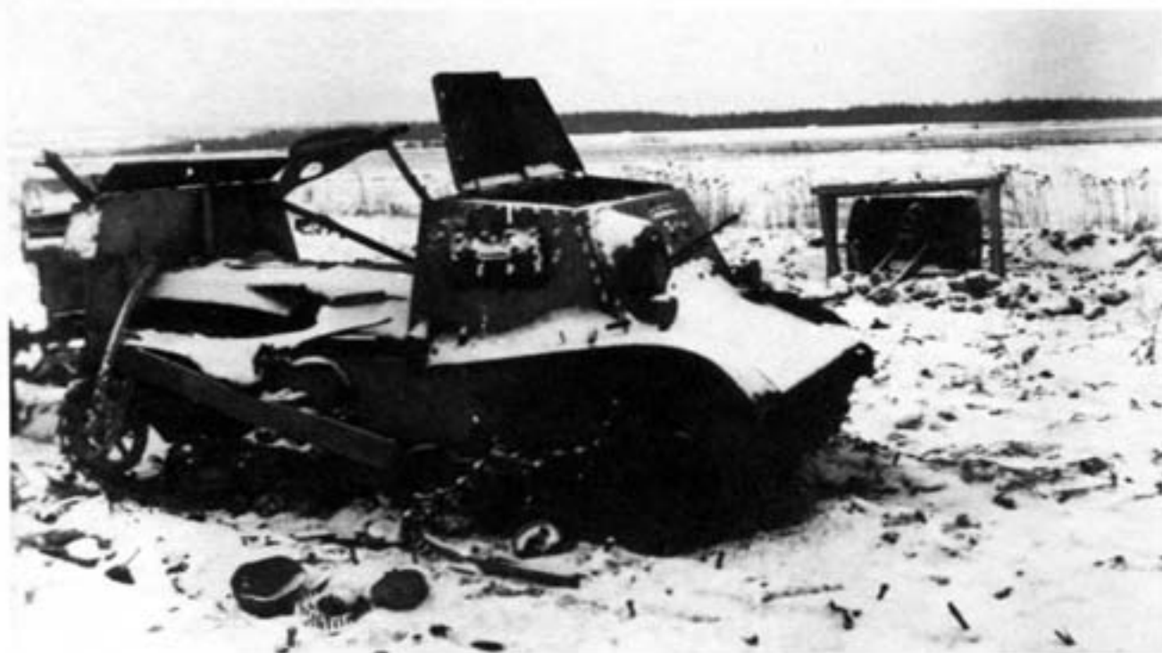
Полубронированный тягач «Комсомолец» и 76-мм полковая пушка образца 1927 года, разбитые огнем немецких танков. Снимок сделан 5 декабря 1941 года под Клином в полосе 36-й моторизованной дивизии вермахта. Обращает на себя внимание навес над орудием, служащий для маскировки от авиации.
