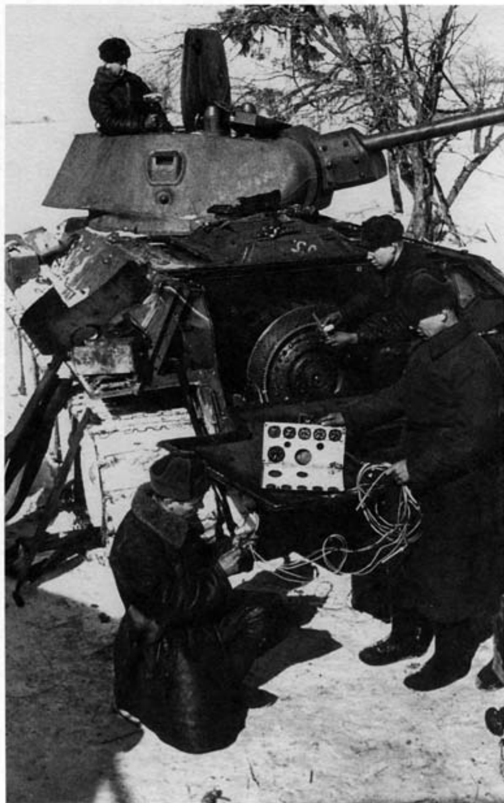
Ремонт танка Т-34 в полевых условиях. Западный фронт, ноябрь 1941 года. Благодаря откидному верхнему кормовому листу ремонт тридцатьчетверки значительно облегчался, что было немаловажно для войск.
