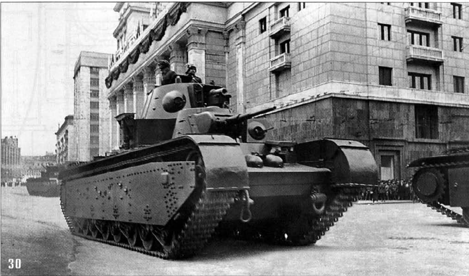
30, 31. Т-35 по пути на Красную площадь 7 ноября 1940 года. Оба танка выпуска февраля — апреля 1939 года. Хорошо виден люк механика-водителя толщиной 70 мм, а также специальные брызговики на кромках подгусеничных полок. Кроме этого парада, такие брызговики больше на фотографиях не встречаются. Обращает внимание, что танк на фото 31 оборудован поручневой антенной (АСКМ).
